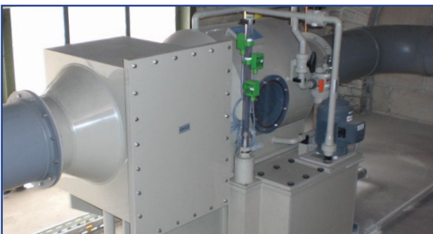
Abluftneutralisationsanlage
